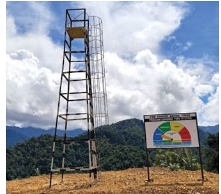
Fire Tower (FMU T/3370)
